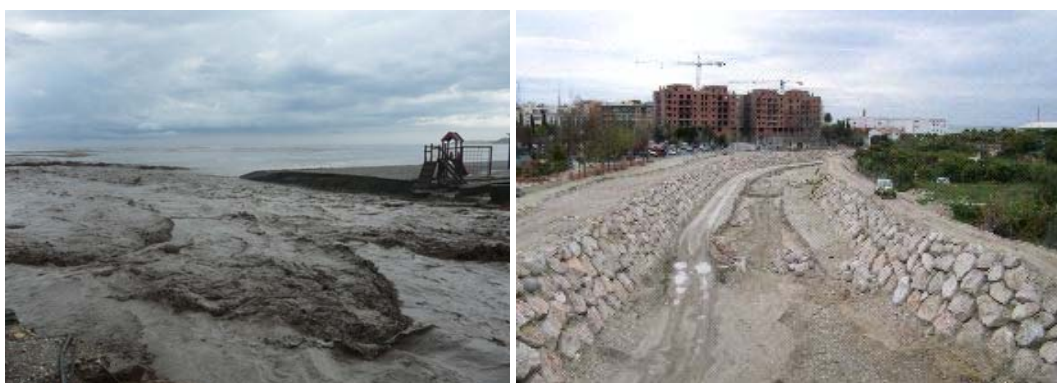
Figura 7. Fotografías de la desembocadura del río Chillar en episodio de avenida (izq.) y de las obras de encauzamiento de éste (dcha.).
