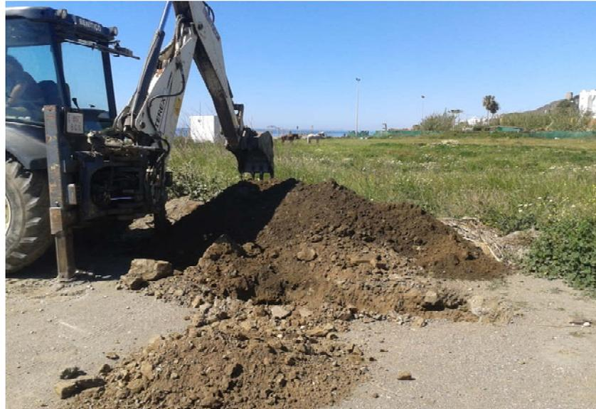
Figura Nº 4.- Imagen de la ejecución de las calicatas de reconocimiento efectuadas.
