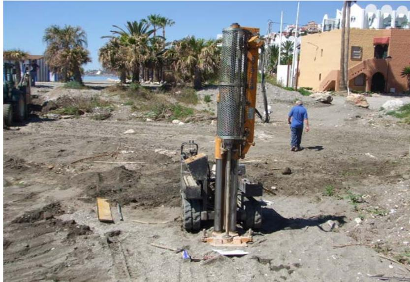
Figura Nº 2.- Trabajos para la ejecución de la penetración dinámica, referida como P-02.
